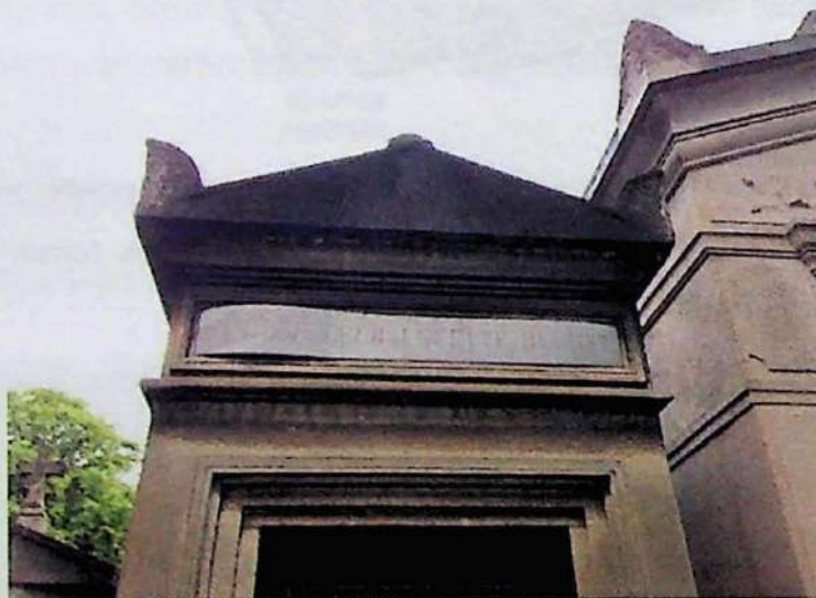
Figura 55: Deformação de placa de Mármore de Carrara.
