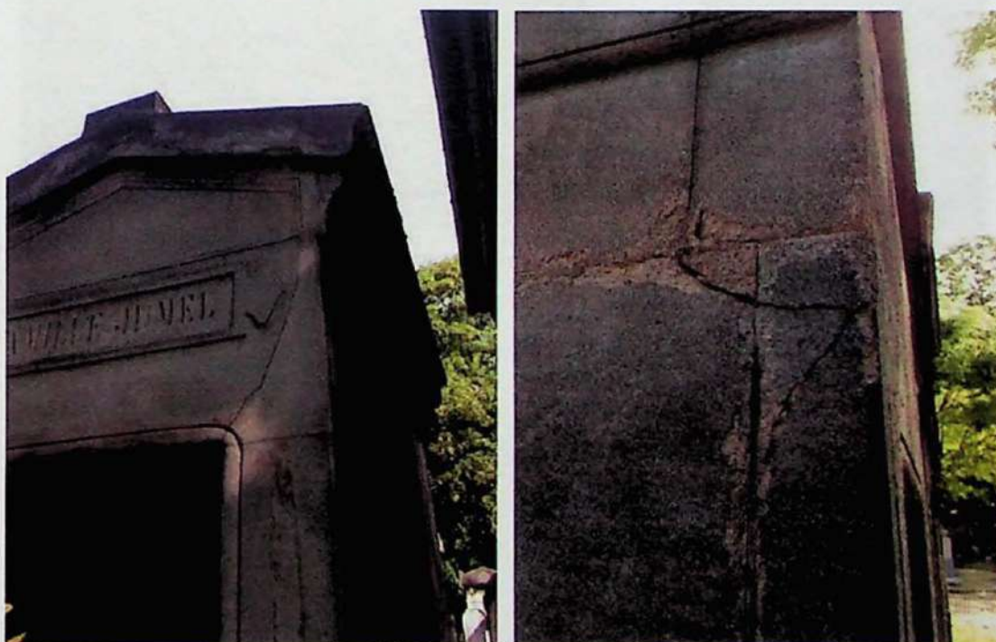
Figura 53: Fratura em jazigos de pedra calcária.
