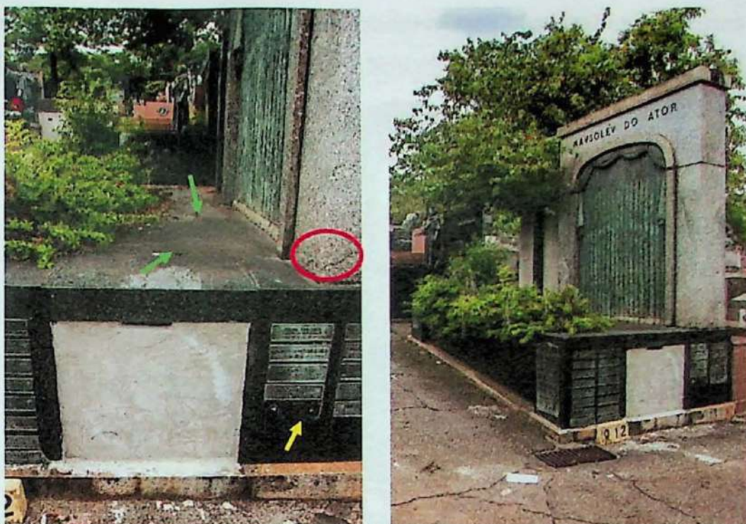
Figura 33.: Vista geral do "Mausoléu do Artista" (à direita) e detalhes das formas de degradação (à esquerda), com acumulação de espessa camada de sujeita (setas verdes), fraturas (círculo vermelho) e falta de peças (seta amarela).
