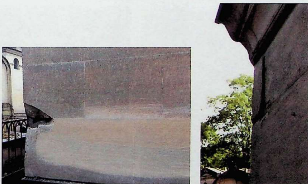
Figura 57: Quebra irregular causada por aumento da pressão interna em calcário grosso, na foto da esquerda houve quebra e perda de material, na foto da direita a porção danificada ainda encontra-se no local da quebra.
