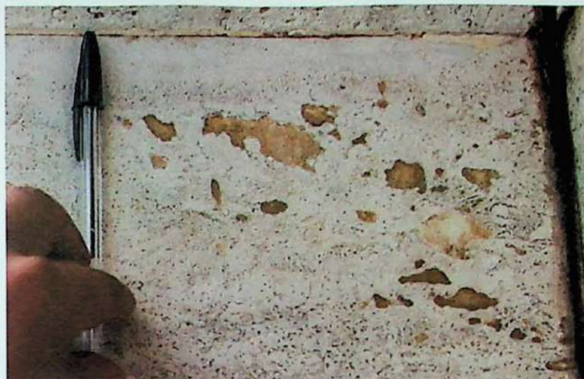
Figura 46: Resina utilizada para preencher os poros da rocha, com o tempo o produto utilizado reage com os agentes intempéricos, modifica-se e adquire cor diferente da inicial, que deveria ser mais próxima da cor da rocha.
