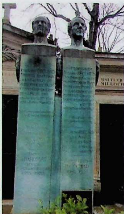
Figura 63: Depósito de cobre (à esquerda) que confere coloração verde azulada para a rocha calcária e depósito de ferro de cor ocre-marrom, à direita.
