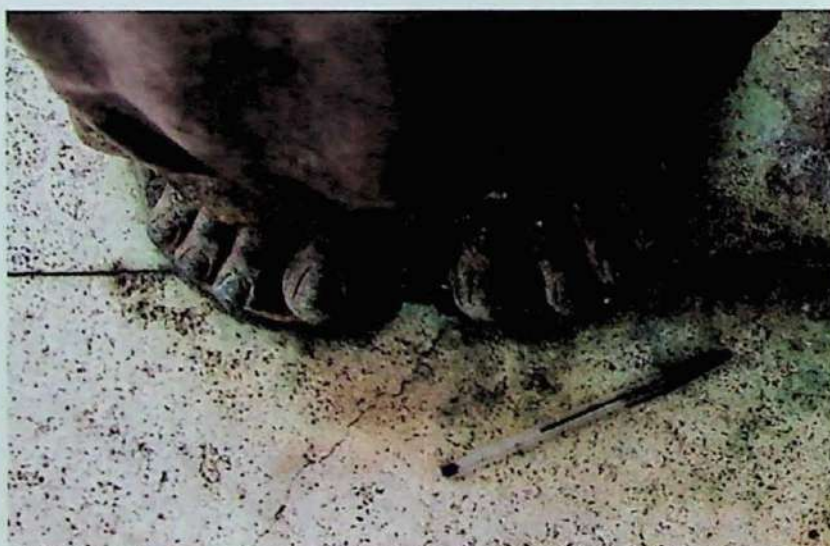
Figura 45: Manchas esverdeadas no travertino, por causa da lixiviação do cobre presente nas esculturas de bronze.
