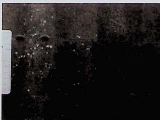
Figura 62: Crosta negra em rocha calcária.
